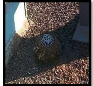
**#4.** Les drains de vos toitures ne doivent pas être obstrués et doivent être en état de bien recevoir les eaux de pluies;
